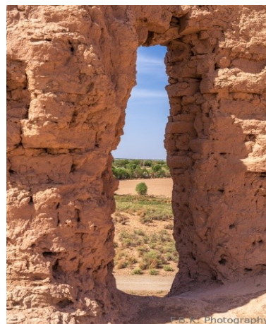
1-rasm. Tuproq-qal'a (Ellikqal'a tumani, Qoraqalpog'iston): xom g'ishtdan qurilgan devorlarning holati
