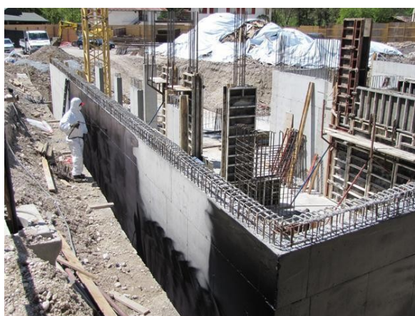
2-rasm. Beton poydevorini namlik va yer osti suvlaridan himoyalash jarayoni
